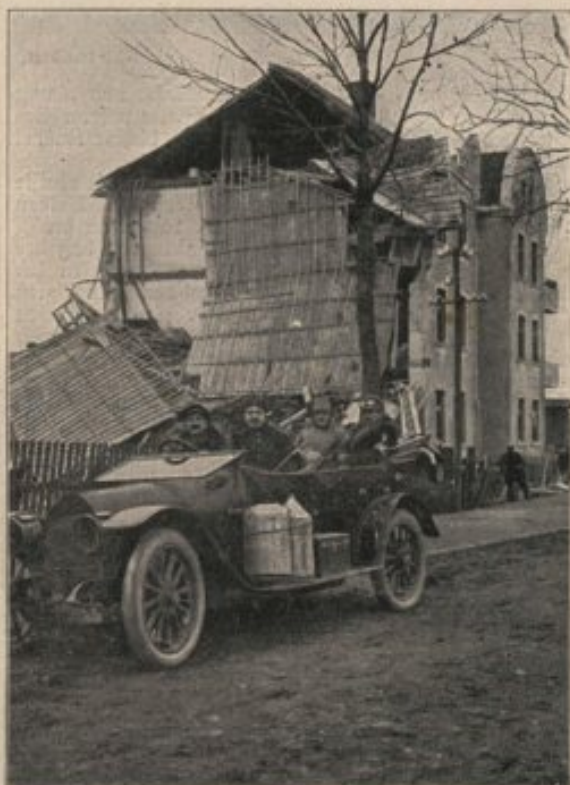
Durch Granaten zerstörtes Haus in Wieballen.
